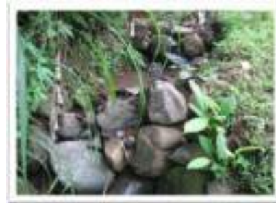
Bangunan Terjunan Air
