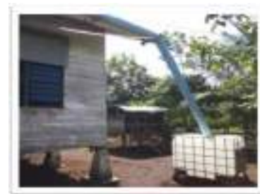
Penampungan Air Hujan
